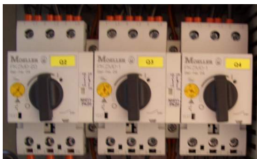
Рис. 1 Защитный автомат двигателя
