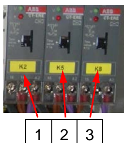
Рис. 52: Значения настройки реле времени
